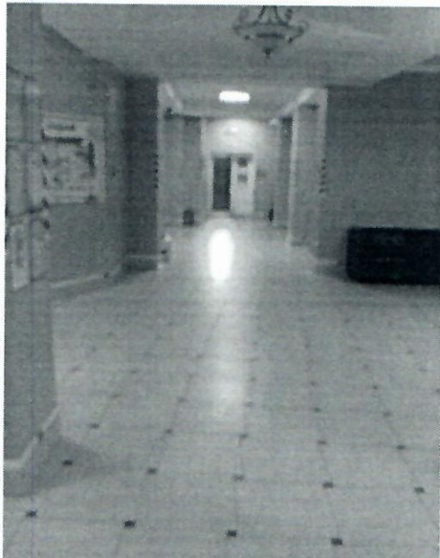
КЕП. пути эвакуации Фото 21
