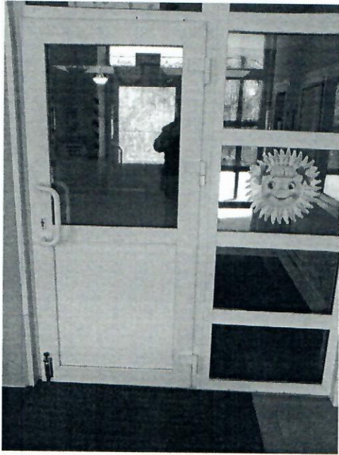
КЕП. дверь внутри здания фото20
