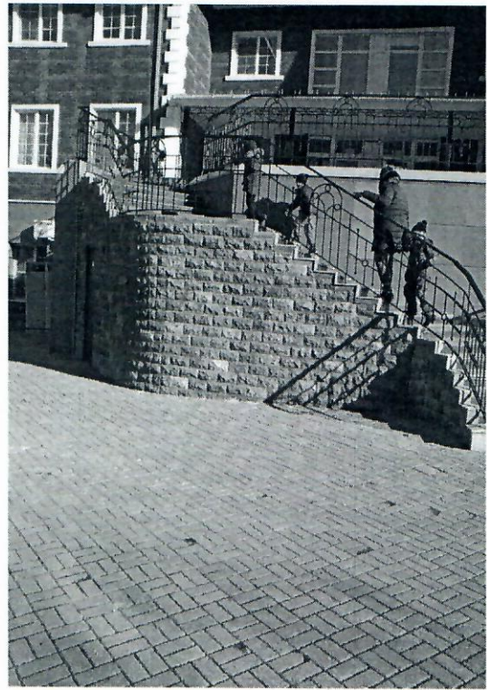
КЕП. Лестница. наружная фото 8
