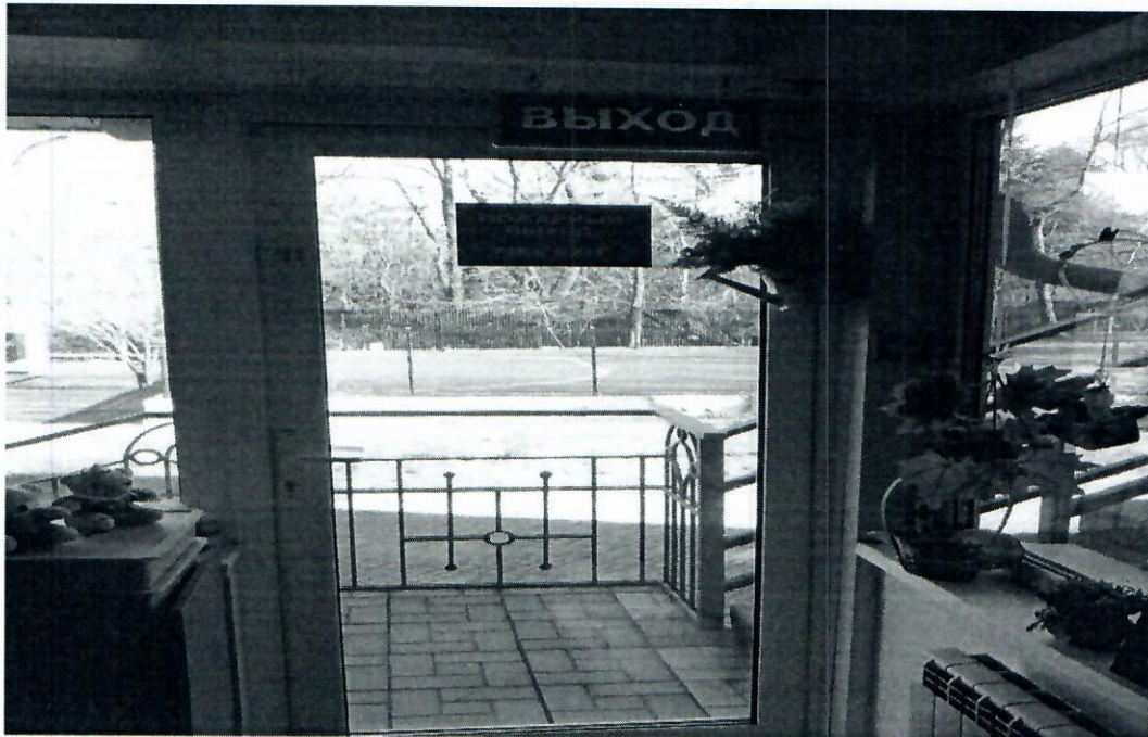
КЕП. Пути эвакуации. Фото 24
