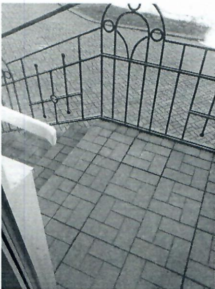
КЕП. Лестница наружная фото 9
