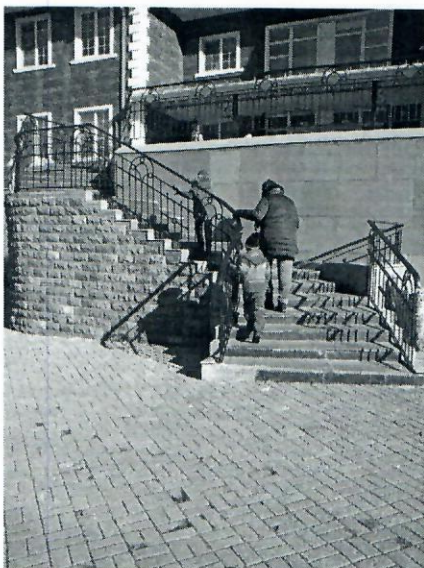
КЕП. Наружная лестница фото 7
