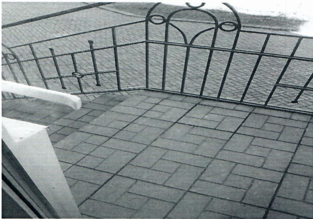
КЕП. Лестница наружная фото 9
