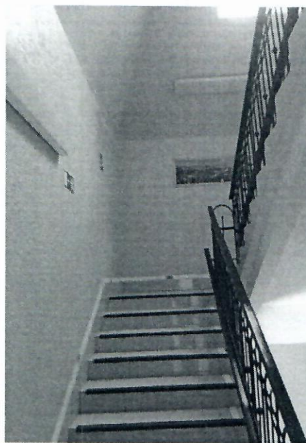
КЕП. лестница внутри здания фото 17
