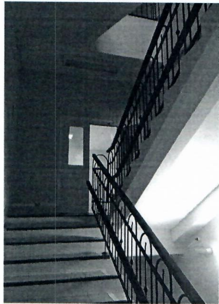
КЕП. Лестница внутри здания. Фото
